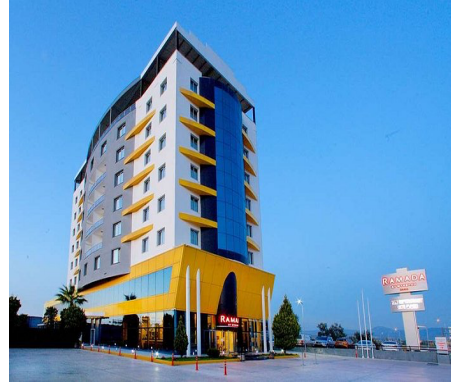
SOMA RAMADA OTEL TADİLAT (RENOVASYON) 2023
