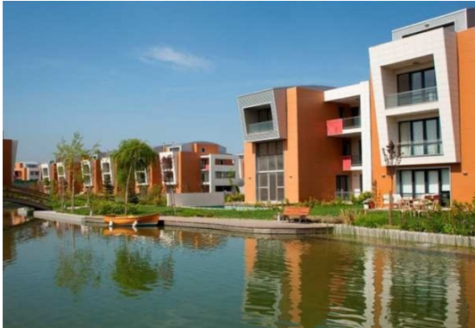
SANCAKTEPE VİLLA TADİLAT PROJESİ (RENOVASYON) 2022
